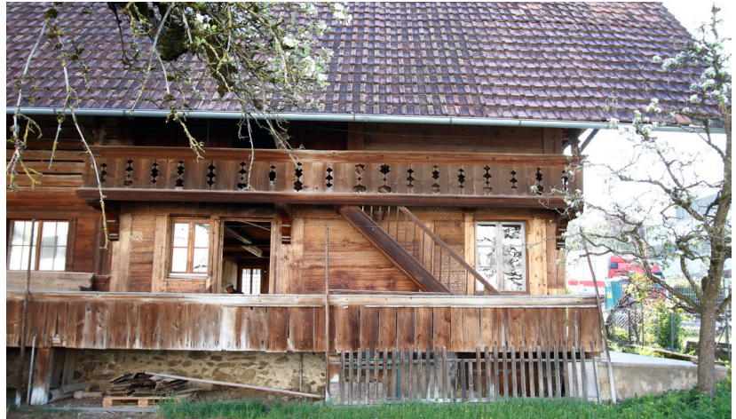
Die Schrift beginnt an Bundbalken West und endet an Ostseite
