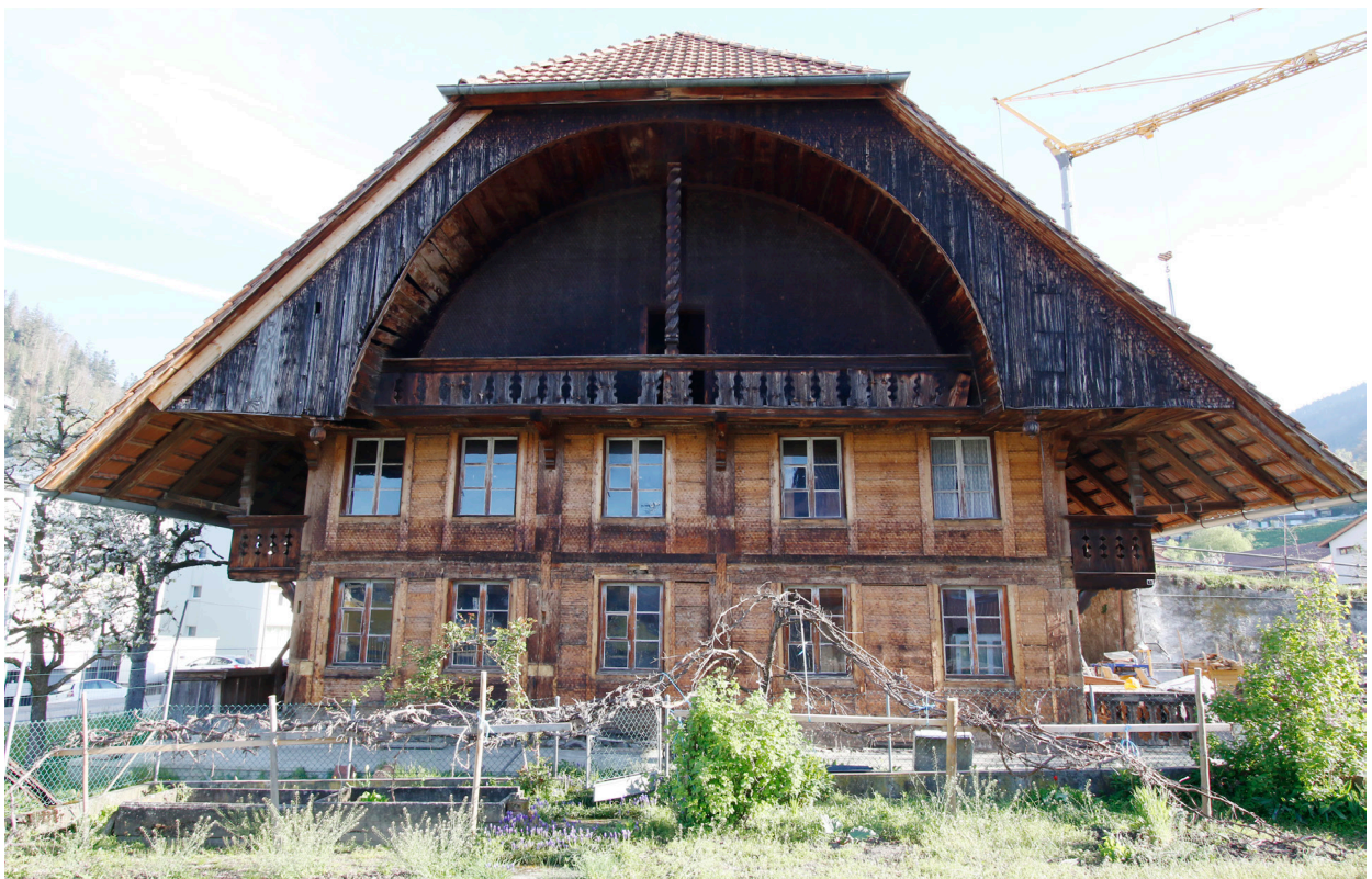
Ist-Zustand der Fassade 2024
